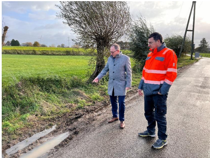
Bürgermeister Sebastian Hense und Bauhofleiter Stefan Tekaas bei der Begutachtung der Fahrradstraße „In de Pentges in Millingen“
