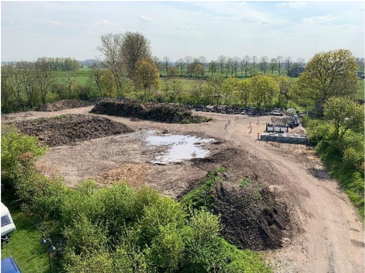
Kompostplatz der Stadt Rees an der Bergswicker Str.
